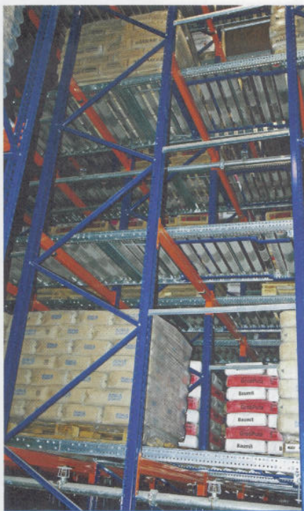
Im Durchlaufregal wird die superschnell-drehende Sackware von hinten beschickt und läuft auf Rollen durch
